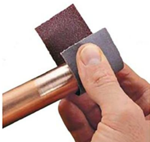
зачистить внешнюю поверхность трубы
