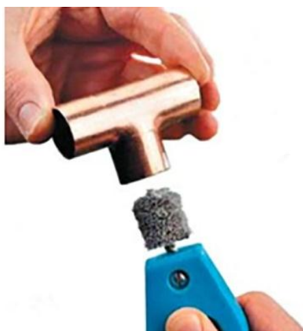
зачистить раструб фитинга
