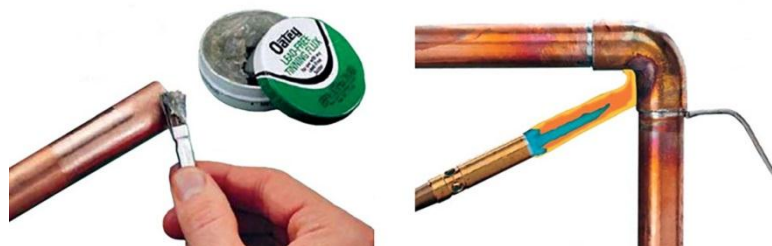
Рисунок 4.30 – Покрытие труб флюсом и пайка
