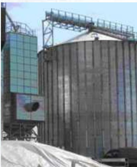
Силосы зерновые СГ, СВ предназначены для приема чистого и сухого зерна, долговременного хранения зерна с послойным контролем температуры, с многократной загрузкой и выгрузкой, с контролем верхнего и нижнего уровня заполнения, защиты зерна от порчи грызунами и птицами, защиты зерна от атмосферных осадков.
