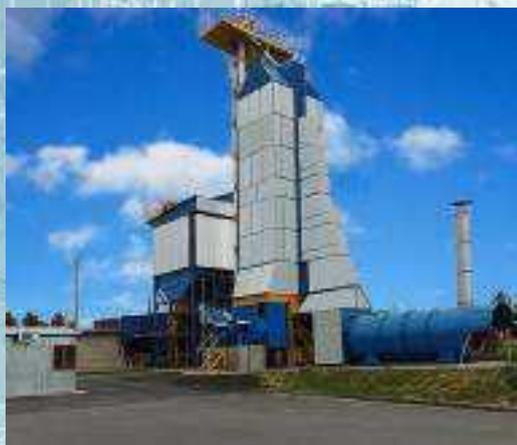
Сушилка зерновая шахтная модульная СЗШМ-30 стационарная открытого типа, применяется для сушки зерна и семян зерновых колосовых, зернобобовых, кукурузы и крупяных культур в сельском хозяйстве.
