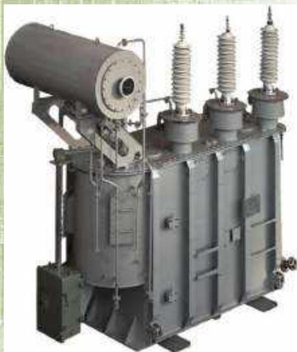
ТДН-10000/110 У1 - стационарный силовой масляный трехфазный двухобмоточный трансформатор мощностью 10000 кВА напряжением 110 кВ общего назначения с регулированием напряжения под нагрузкой, с системой охлаждения вида «Д» - принудительной циркуляцией воздуха и естественной циркуляцией масла, предназначен для работы в умеренном климате в условиях наружной установки. Климатическое исполнение У, категория размещения 1 по ГОСТ 15150
